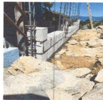
Foto 6: Sustitución de muro perimetral de maya hg
