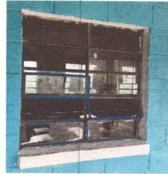
Foto 2: sustitución de ventana de metal por metal
