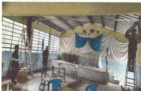
Foto 5: Sustitución de cableado eléctrico
